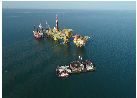
渤海秦皇岛-曹妃甸油田群岸电项目
