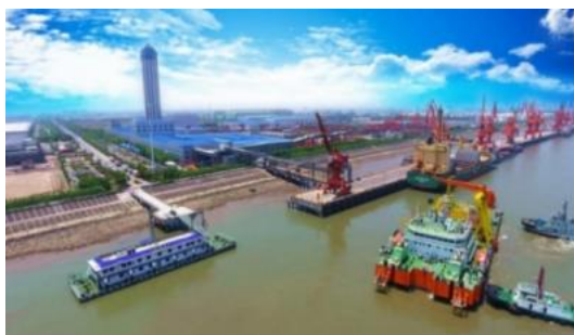
亨通国家电网舟山项目
