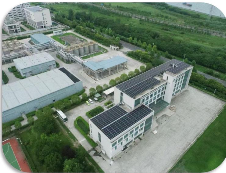
图：美思德屋顶光伏发电项目
