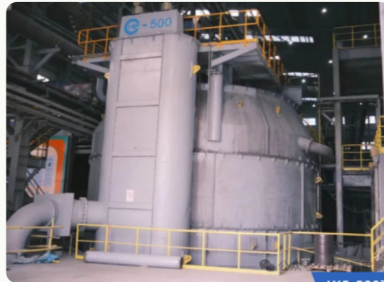
塞尔维亚某铜矿 | HIF-500 型浮选机尾矿铜回收应用
