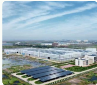
沧州公司厂区分布式光伏发电项目
