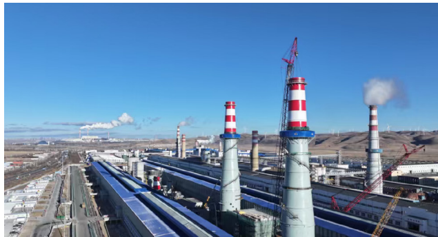
沈阳院扎哈淖尔 35 万吨绿电铝项目
