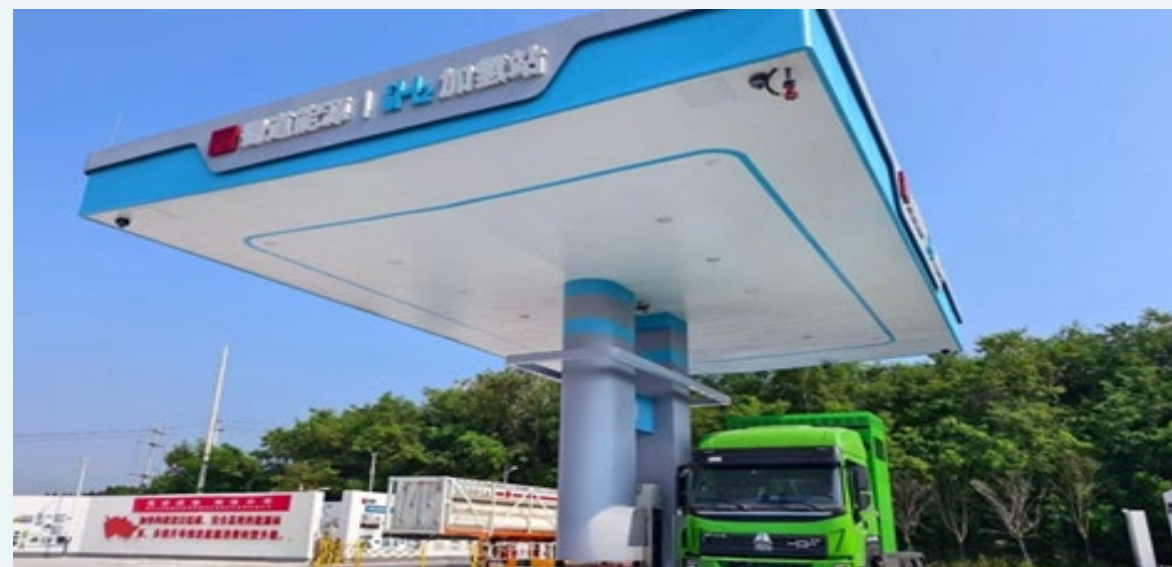
渝蓉高速简阳服务区加氢站投入使用
