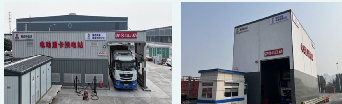
龙泉民生物流园001号电动重卡换电站与资中服务区换电站
