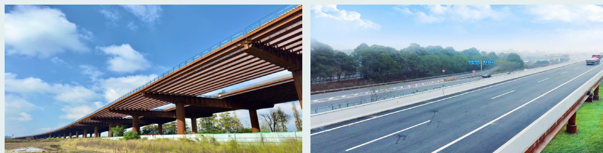
高性能自密实混凝土的应用
