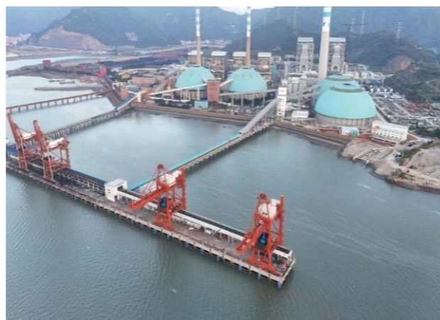
华电科工新一代四卷筒抓斗卸船机 无人值守系统实现重载运行
