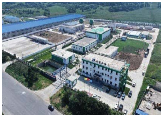
华电科工辽宁华电铁岭 25MW 离网风电制氢一体化项目
