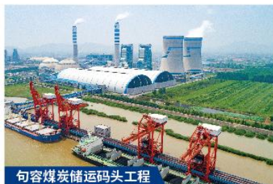
句容煤炭储运码头工程
