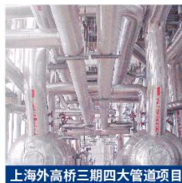
上海外高桥三期四大管道项目
