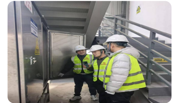
公司领导带队对分布式光伏项目进行质量安全检查
