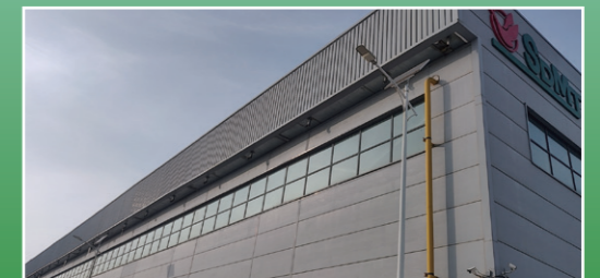
厂区太阳能路灯
