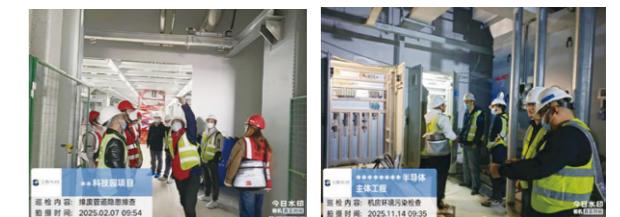
▲ 排废管道隐患排查
