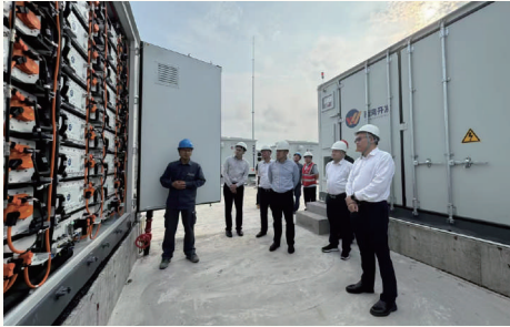
公司领导赴深南电中山南朗独立储能项目现场慰问
