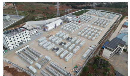
百兆瓦时级构网型储能系统黑启动试验 (南方电网区域内首次成功)
