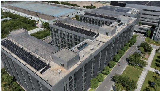
工业园区源网荷储一体化项目（屋顶光伏）
