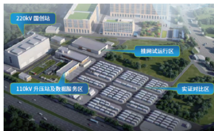
白云储能实景验证基地
