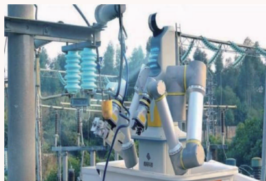
“擎天”配网带电作业系统
