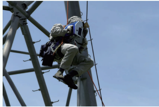
无人机自动挂载柔性升降轨道至导线，作业人员身着屏蔽服，通过“小飞人”的电动升降系统，仅用3分钟便平稳抵达35米高空完成补销任务
