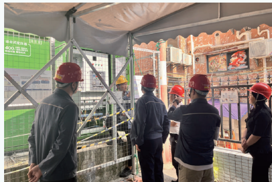
江夏片区低压透明化方案已通过广州供电局现场验收
