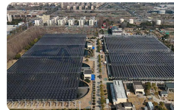
安庆首创水务城东污水处理厂光伏发电项目
