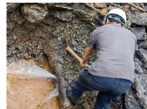
花园新村漏点修复现场施工
