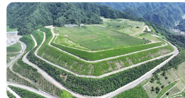
采矿场及排土场区域生态恢复治理
